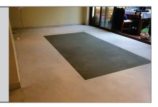
Aplicación de MD FINISH diluida a 40% an agua Sellado del microcemento
